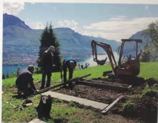
La panchina gigante in costruzione a Civenna
